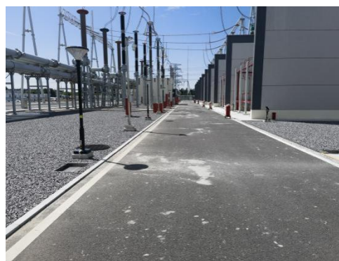
站内道路硬化
