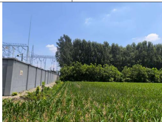
站址南侧围墙
