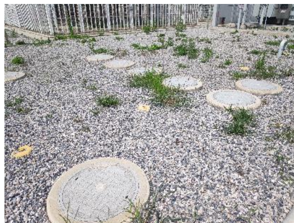
主变事故油池
