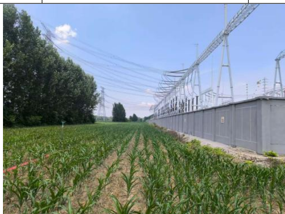
站址西侧围墙
